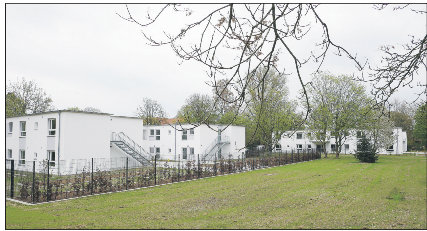
Nach zweijähriger Bauzeit wurden die neuen Wohnhäuser ihrer Bestimmung übergeben.
